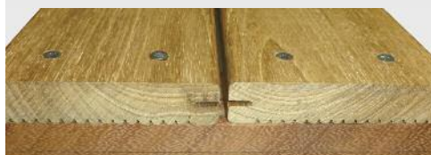
Esempio di posa con viti
